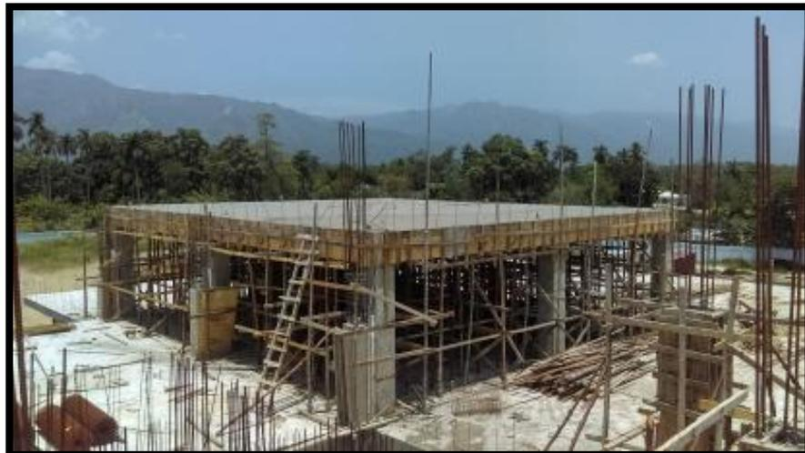
VACIADO DE LOSA DE TECHO DEL 2do NIVEL
