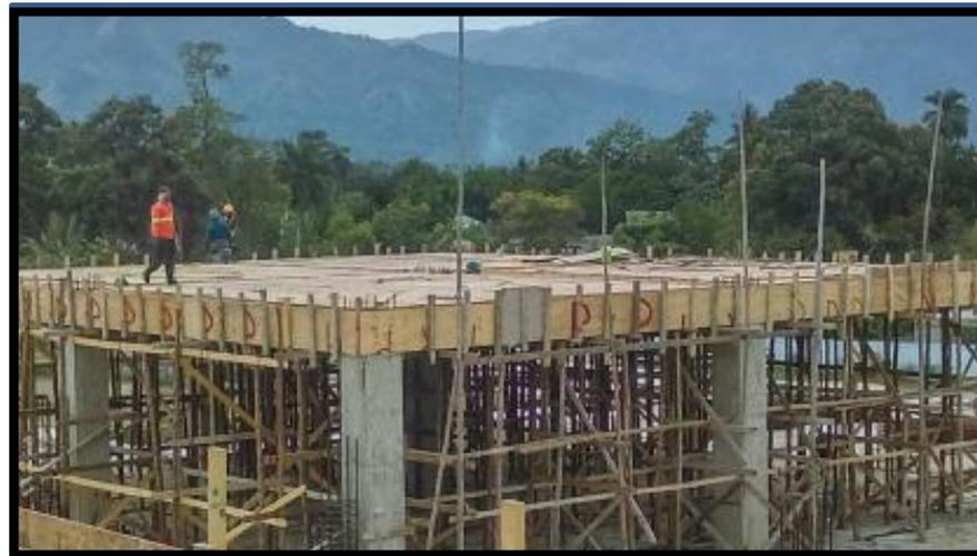
**ENCOFRADO DE LOSA DE
