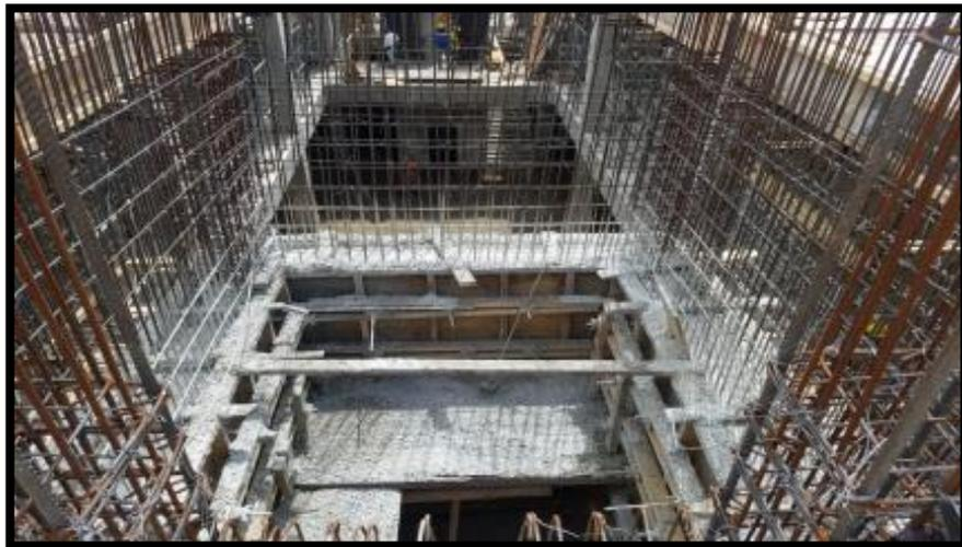
**VACIADO DEL 1er MURO DE ASCENSOR
