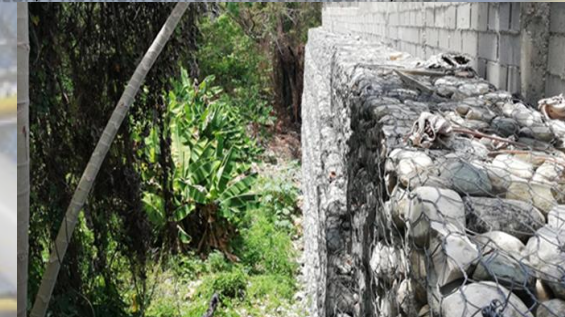
CONSTRUCCION DE MURO DE GAVION EN HAINA, PROVINCIA SAN CRISTOBAL, R.D.
