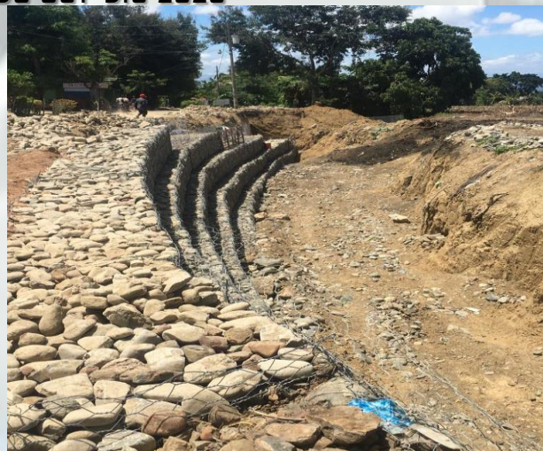
CONSTRUCCIÓN CARRETERA LAS MORAS - EL FUNDO, PROV. ESPAILLAT
