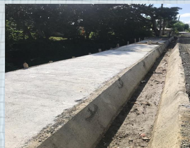
CONSTRUCCIÓN CARRETERAS LAS MORAS - EL PERÚ, PROV. ESPAILLAT
