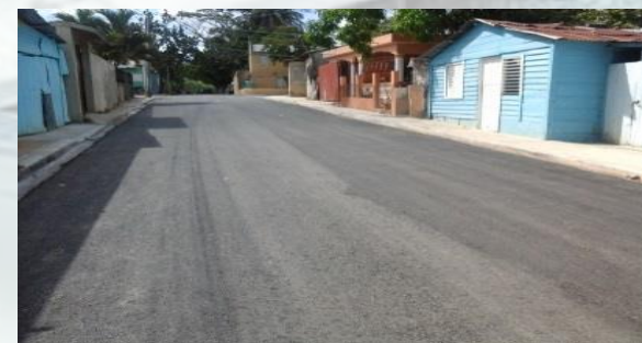
RECONSTRUCCIÓN DE LAS CALLES DEL BARRIO LAS MERCEDES, MUNICIPIO LOS ALCARRIZOS
