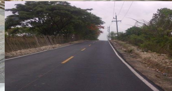
RECONSTRUCCIÓN DE LAS CALLES DEL BARRIO LAS MERCEDES, LOS ALCARRIZOS
