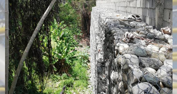
CONSTRUCCION DE MURO DE GAVION EN HAINA, PROVINCIA SAN CRISTOBAL, R.D.
