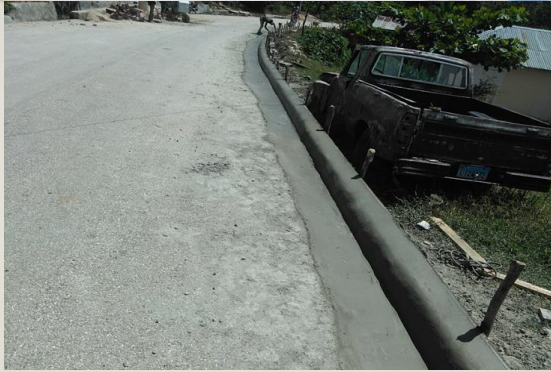
CONSTRUCCIÓN DE ACERAS, CONTENES, CUNETAS Y MOVIMIENTO DE TIERRA EN: EL CERCADO, EL PINAR, JUAN SANTIAGO, LOS GUINEOS Y HONDO VALLE, PROVINCIA SAN JUAN, R.D.
