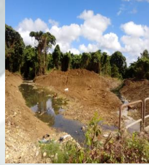
CANALIZACION DEL RIO YAGUASA, PROLONGACION CARRETERA SANCHEZ
