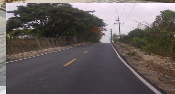
RECONSTRUCCIÓN DE LAS CALLES DEL BARRIO LAS MERCEDES, LOS ALCARRIZOS
