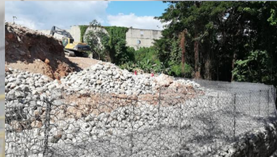
CONSTRUCCION DE MURO DE GAVION EN HAINA, PROVINCIA SAN CRISTOBAL, R.D.
