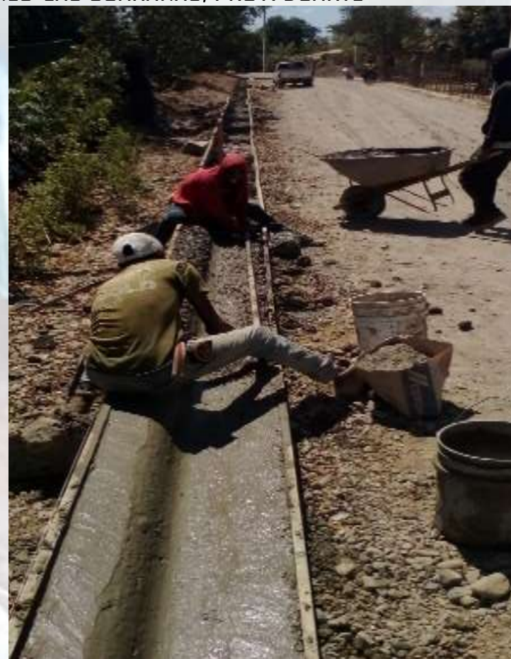
RECONSTRUCCION DEL TRAMO CARRETERO PIMENTEL-LOS LIMONES-LAS GUARANAS, (TRAMO B), PROV. DUARTE
