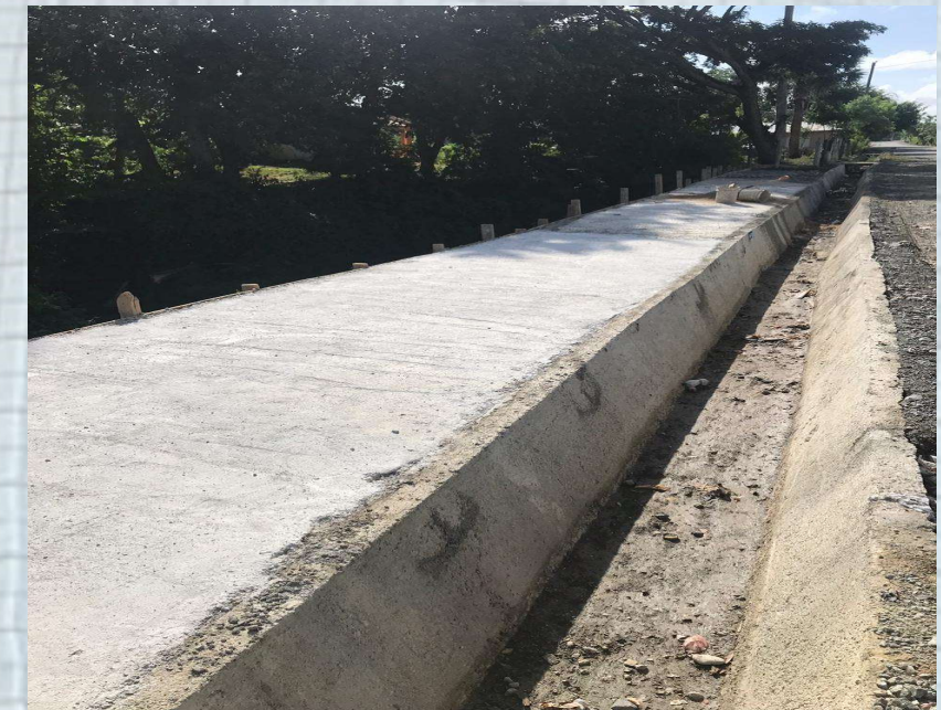
CONSTRUCCIÓN CARRETERAS LAS MORAS - EL PERÚ, PROV. ESPAILLAT
