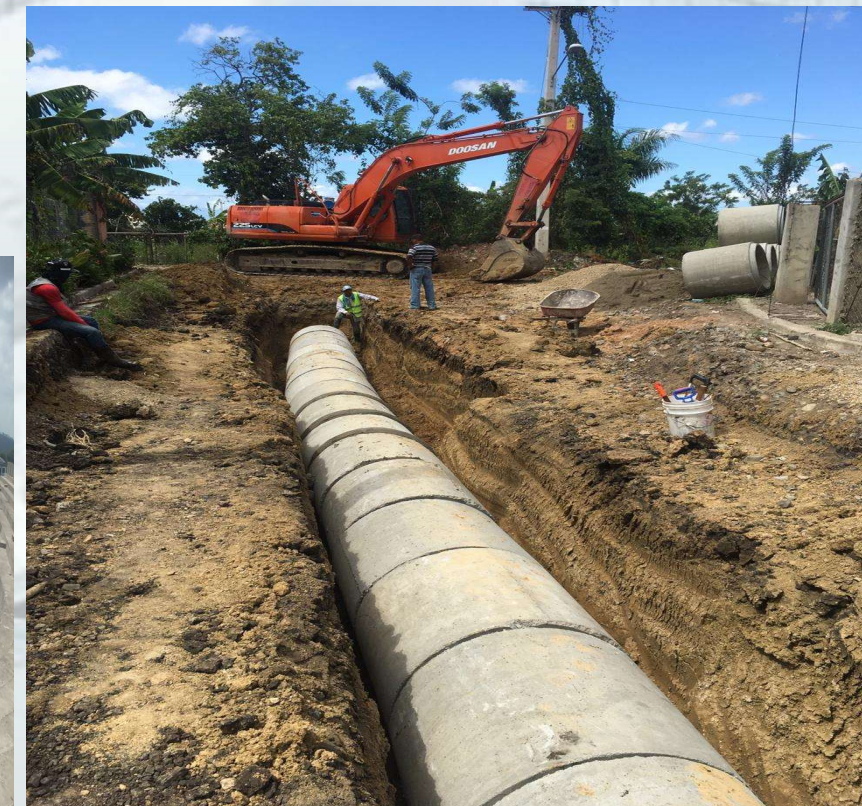
RECONSTRUCCIÓN CALLES BARRIOS KALAC II, BARRIO LAS FLORES Y CALLEJÓN DE TERO, PROV. ESPAILLAT
