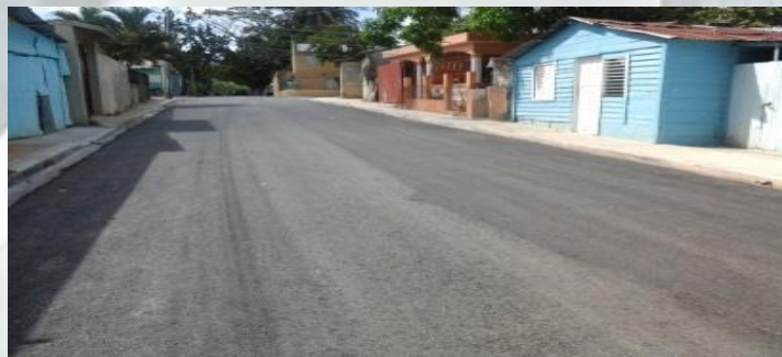
RECONSTRUCCIÓN DE LAS CALLES DEL BARRIO LAS MERCEDES, LOS ALCARRIZOS
