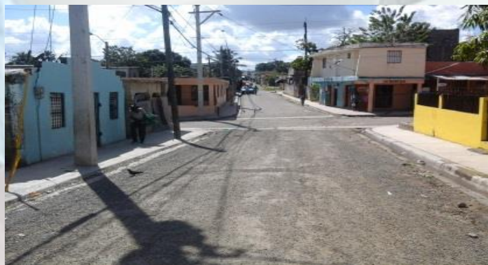
RECONSTRUCCIÓN DE LAS CALLES DE LOS BARRIOS JUANA SALTITOPA Y 24 DE ABRIL, LOS ALCARRIZOS
