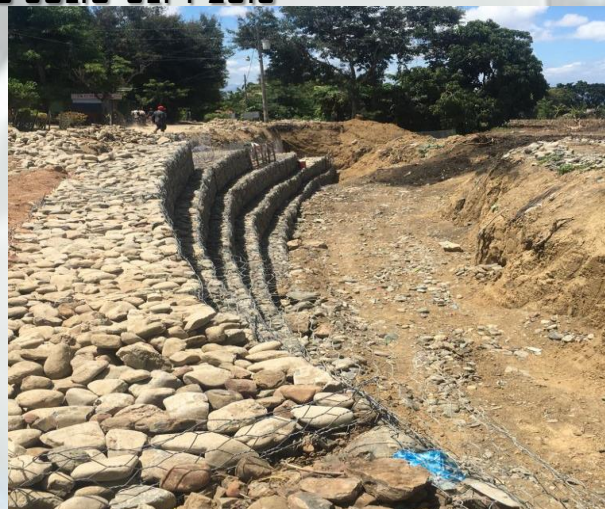
CONSTRUCCIÓN CARRETERA LAS MORAS - EL FUNDO, PROV. ESPAILLAT
