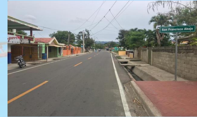
CONSTRUCCIÓN CARRETERAS LAS MORAS - EL PERÚ
