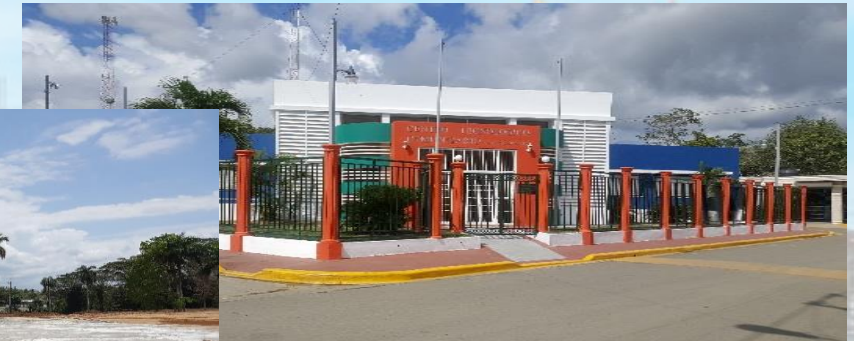
CONSTRUCCIÓN DEL EDIFICIO CENTRO TECNOLÓGICO COMUNITARIO (CTC) LAS GUARANAS
