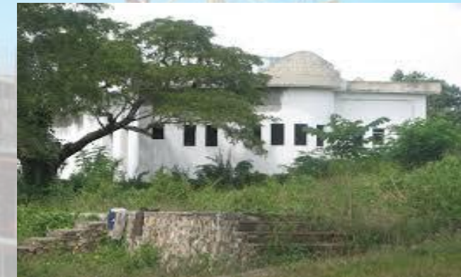
RECONSTRUCCION CASA DE LA CULTURA SEYBO
