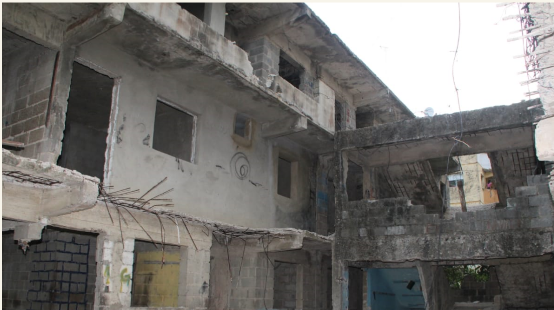
Edificación antes de la reconstrucción.
