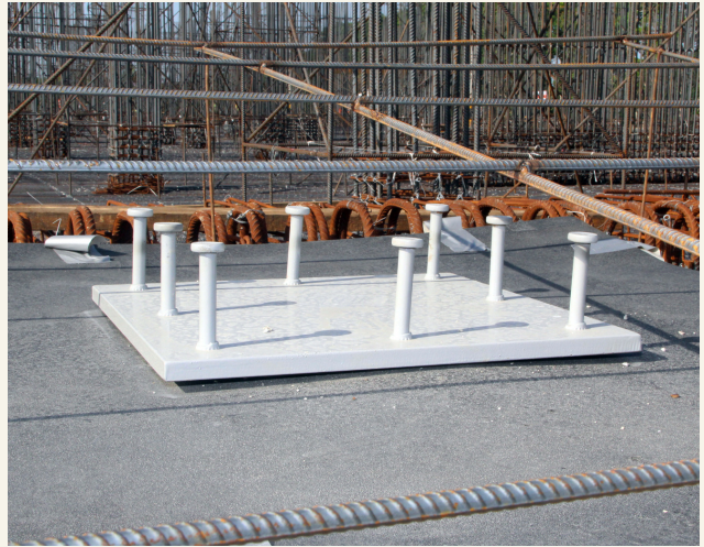
Aislador sísmico
