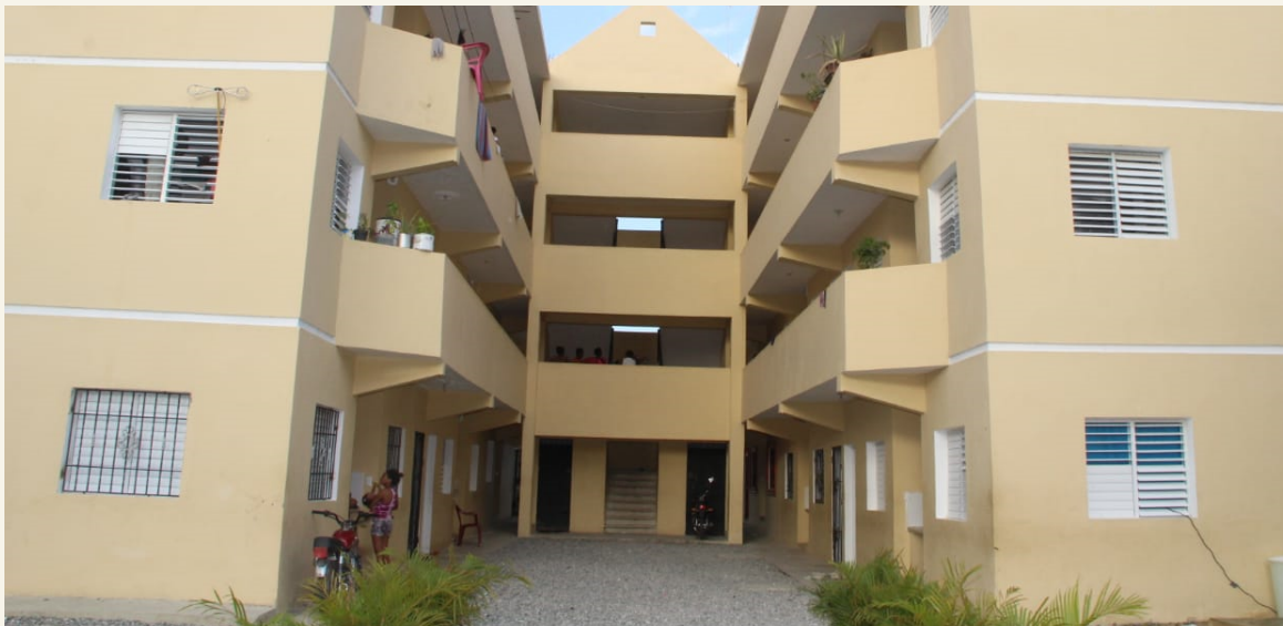
Después de la reconstrucción
