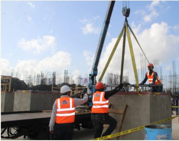
Instalación de aisladores sísmicos
