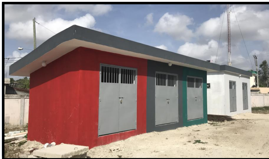
EXTERIOR CASETA DE DEPÓSITO DE BASURA Y CASETA DE GASES MEDICINALES
