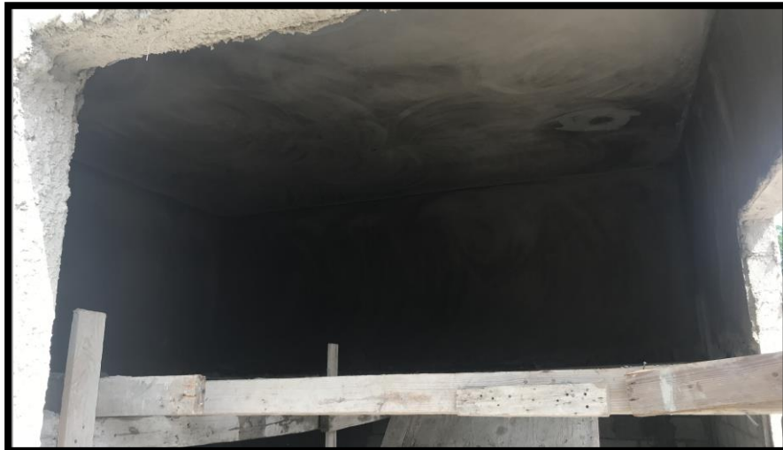
PAÑETE INTERIOR EN MORGUE.
