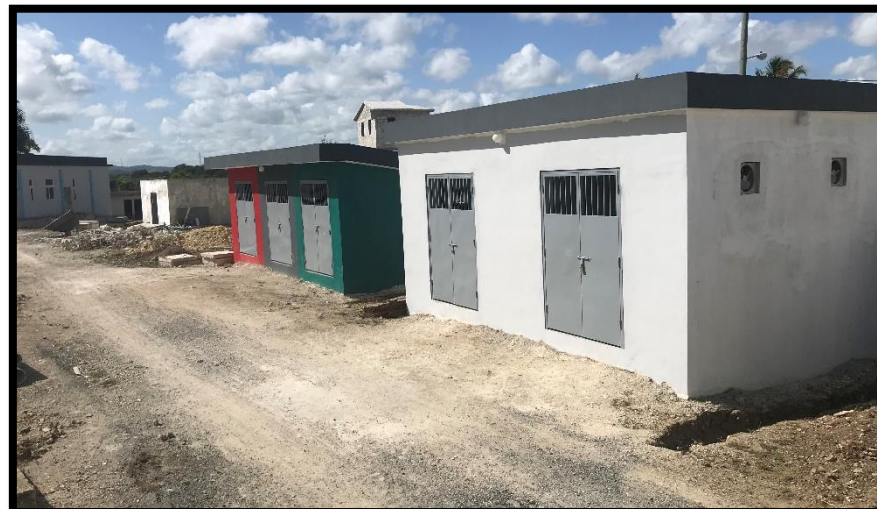
CASETA DE GASES MEDICINALES Y DEPÓSITO DE DESECHO.
