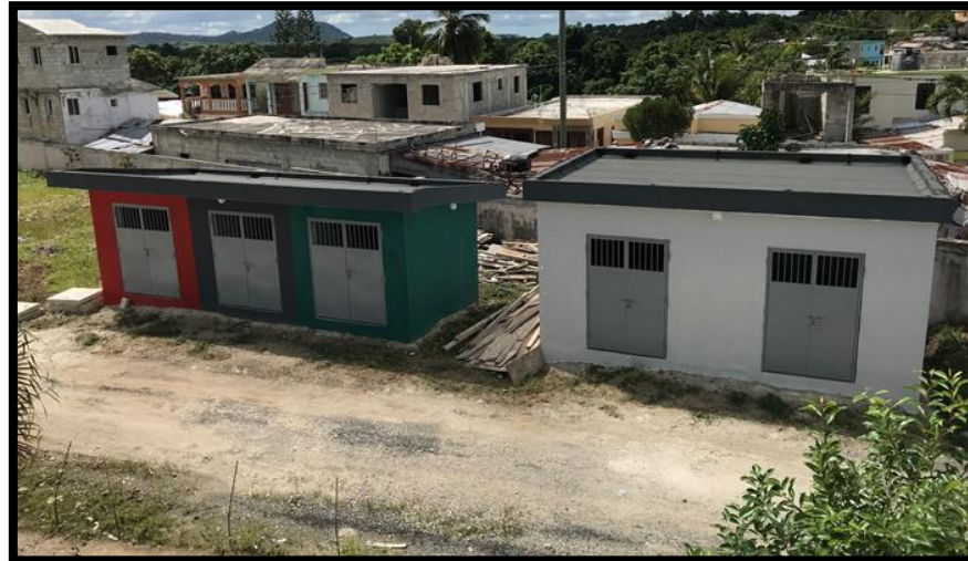
VISTA PANORÁMICA CASETA DE GASES MEDICINALES Y DEPÓSITO DE BASURA
