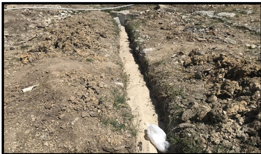
RELLENO EN EXCAVACIONES REALIZADAS PARA SISTEMA DE AGUAS RESIDUALES.
