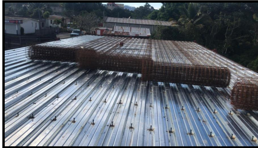
COLOCACION ACERO EN VIGA Y LOSA DEL ENTREPISO
