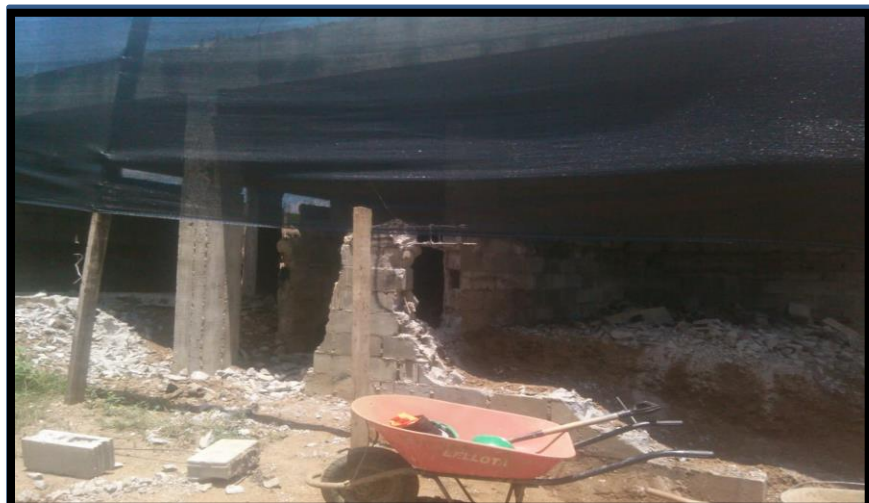
DEMOLICIONES MUROS SOTANO DEL MODULO "C" – "D"
