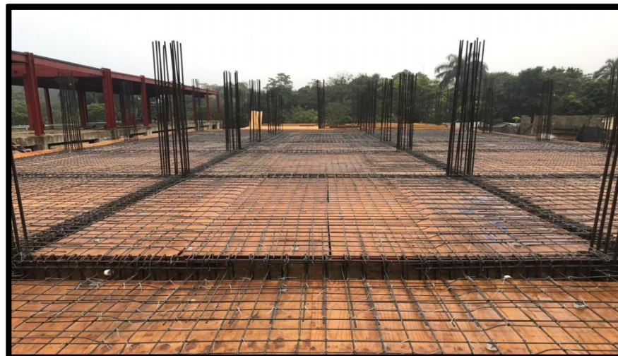
COLOCACION METALDESK Y MALLA ELECTROSOLDADA EN LOSA DE TECHO
