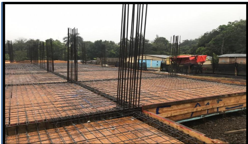
COLOCACION METALDESK Y MALLA ELECTROSOLDADA
