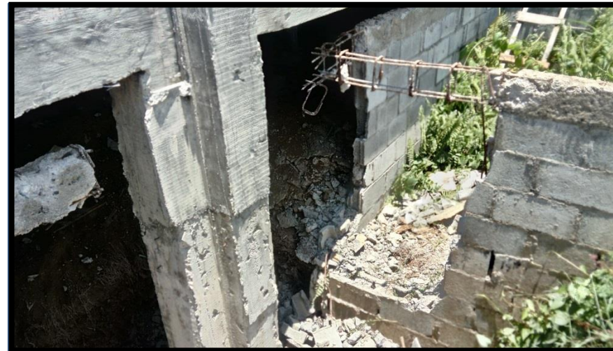
DEMOLICION DE MUROS EN SOTANO
