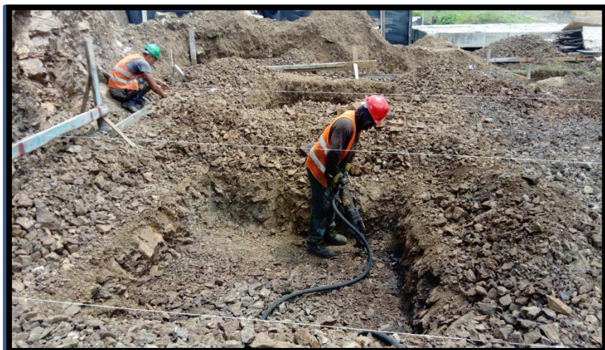
EXCAVACION CON TALADRO Y COMPRESOR
