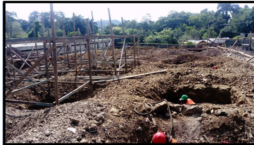
EXCAVACION Y CONSTRUCCION DE CEPÓS
