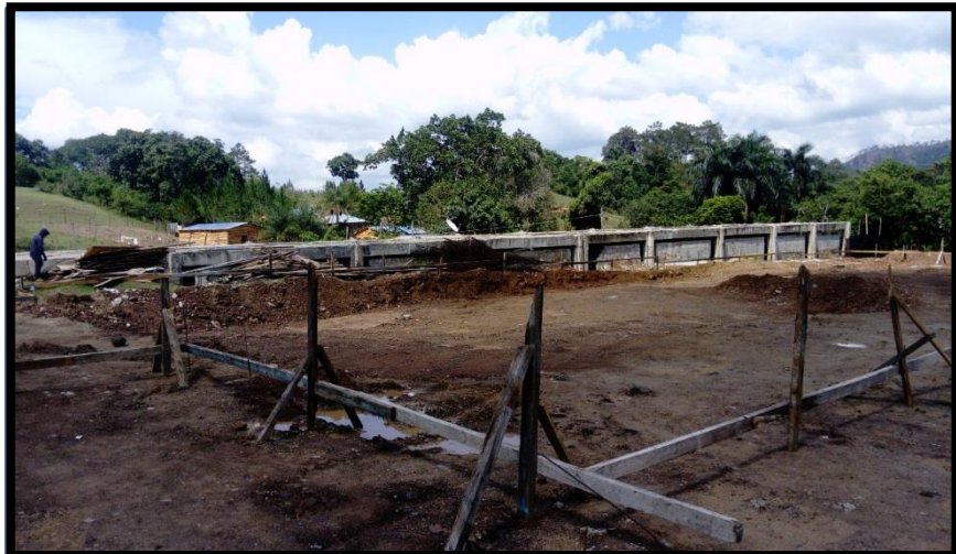
CHARRANCHA PARA REPLANTEO MODULOS "A" – "B"
