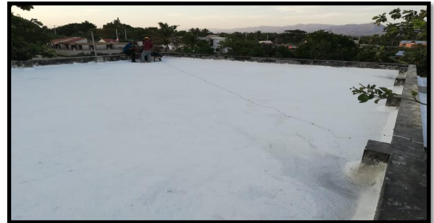
APLICACION DE DRY BLOCKAID SOBRE FINO NUEVO
