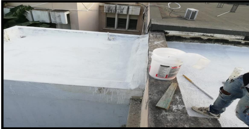
APLICACION DE DRY BLOCKAID SOBRE FINO NUEVO
