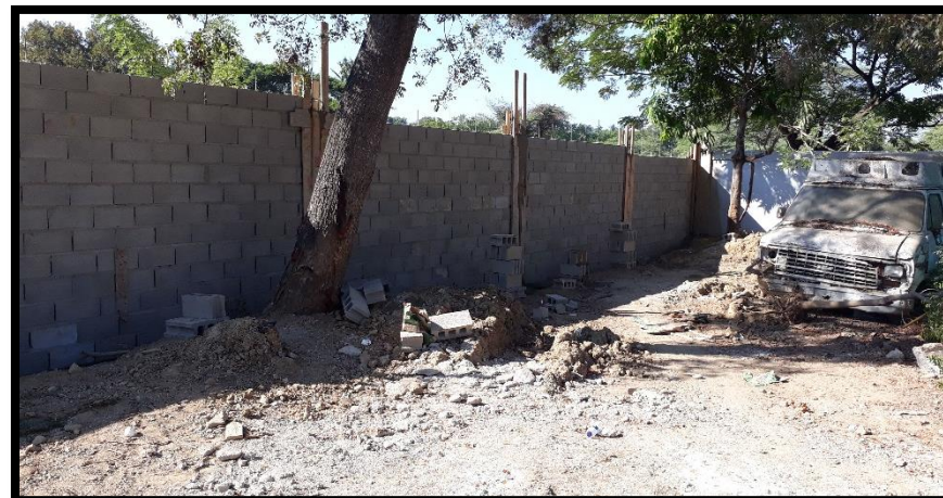
VACIADO COLUMNAS VERJA
