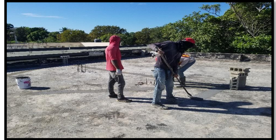
APLICACION DE DRY BLOCKAID SOBRE FINO NUEVO
