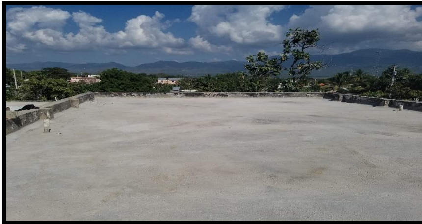
APLICACION DE DRY BLOCKAID SOBRE FINO NUEVO
