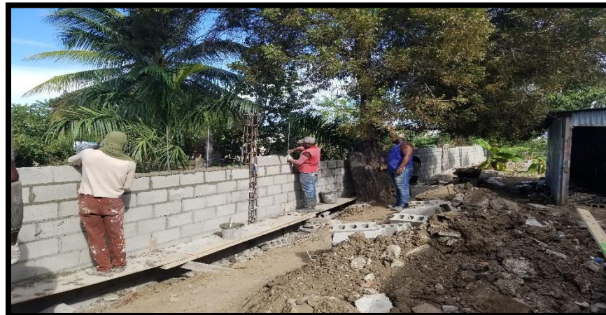
CONSTRUCCION NUEVA VERJA
