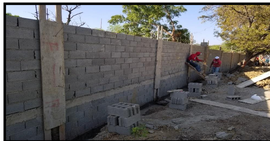
CONSTRUCCION NUEVA VERJA
