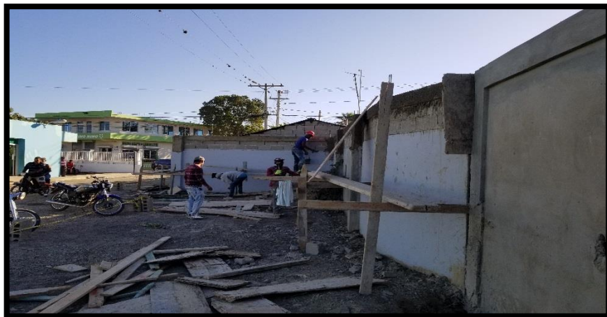
CONSTRUCCION NUEVA VERJA
