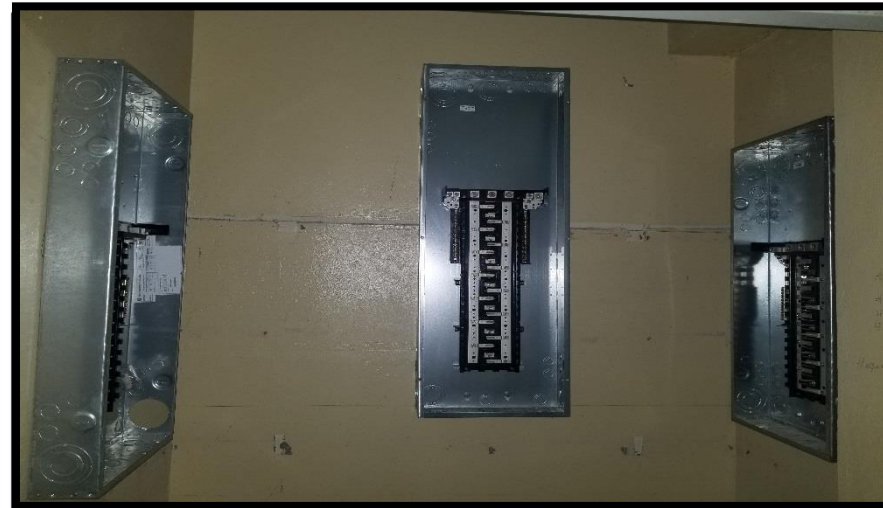
COLOCACION PANELES ELECTRICOS INTERNAMIENTO
