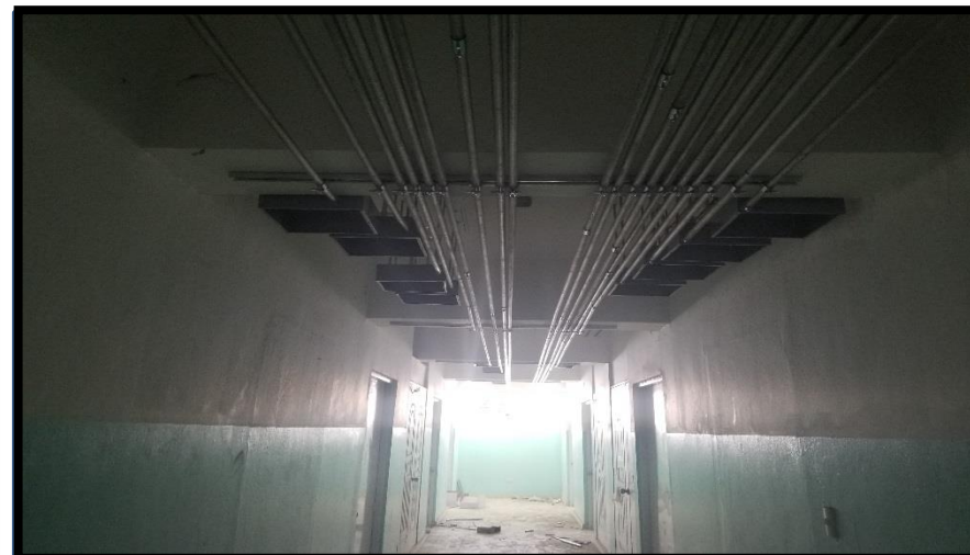
COLOCACION TUBERIAS ELECTRICAS MT
