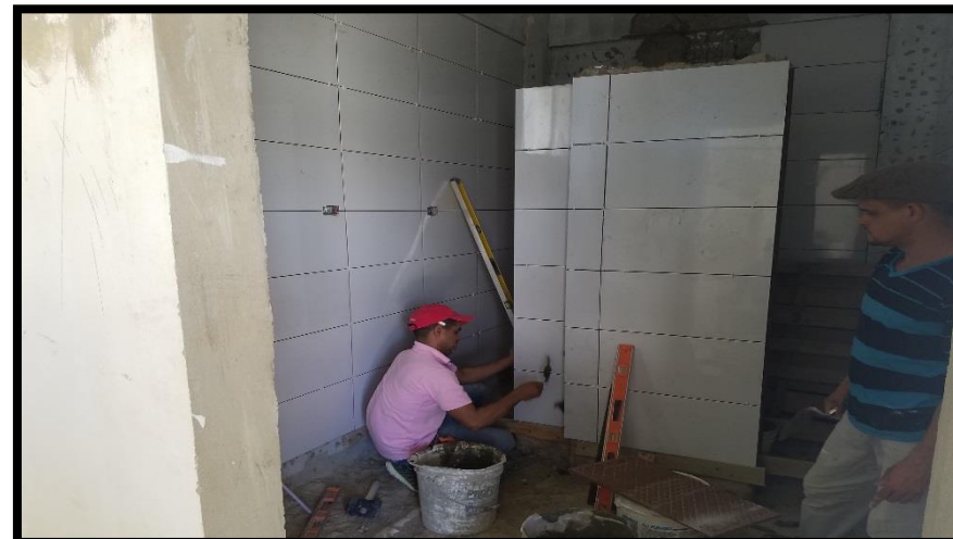
MORGUE COLOCACION DE CERAMICA EN BAÑOS
