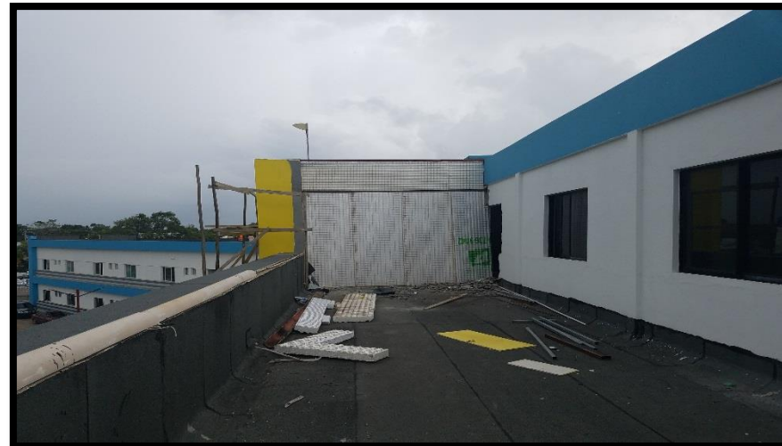
COLOCACION DE MUROS DE PANEL EN TERCER NIVEL
