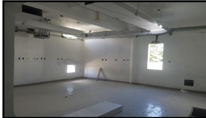
QUIROFANOS INSTALACION DE DUCTOS DE CLIMATIZACION
