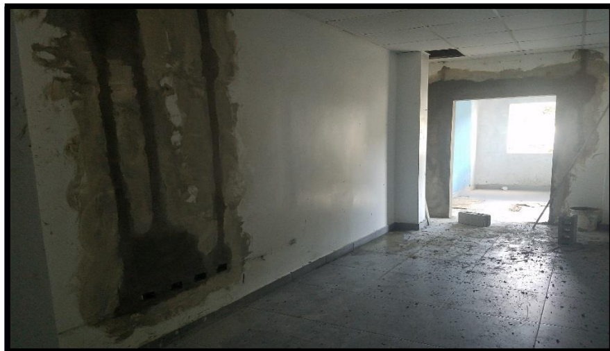
VACUNA TRABAJOS DE RESANES Y CANTOS
