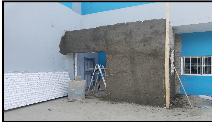
VACUNA COLOCACION DE PAÑETE
