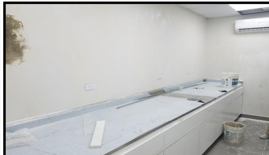
ODONTOLOGIA COLOCACION DE MASILLA EN MUROS
