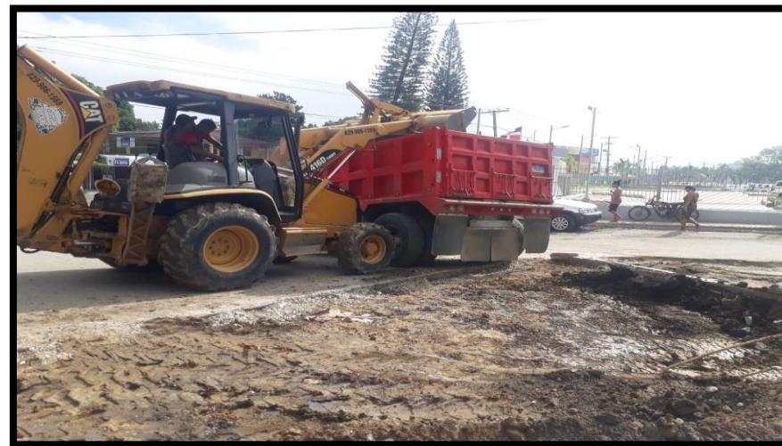
EXTRACCION DE MATERIAL PARA REDISEÑO DE PARQUEOS Y ACCESOS
