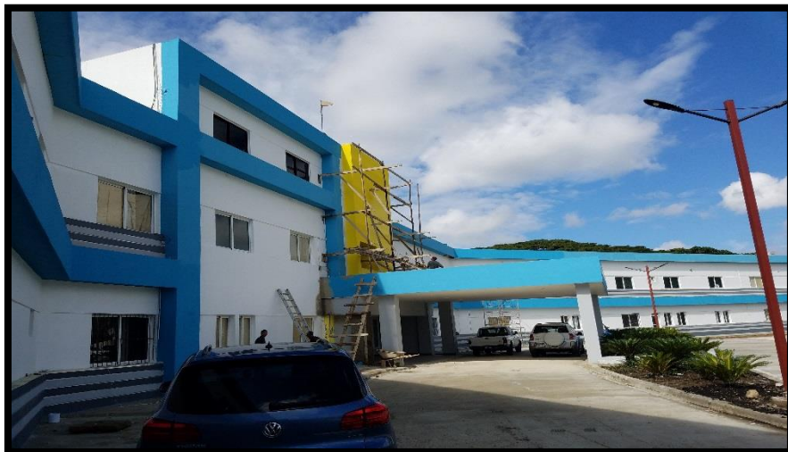
FACHADA PINTURA EN MUROS
