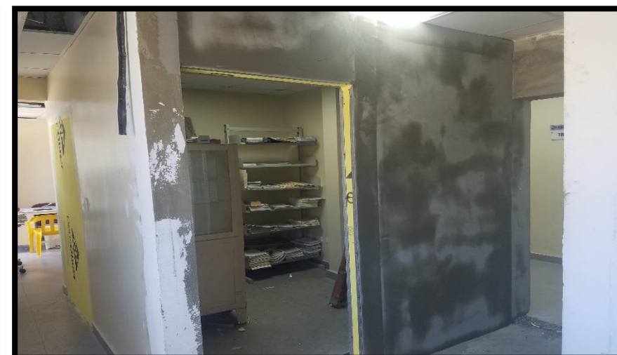
VIH PAÑETE EN MUROS DE DENSGLOSS
