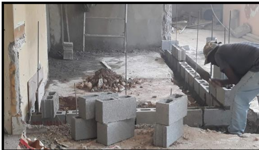
COLOCACIÓN DE BLOCK
