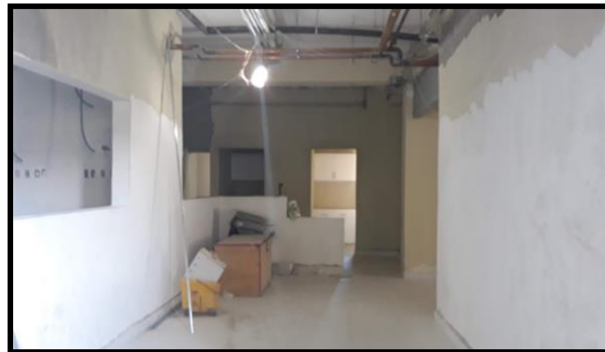
PINTURA: MASILLADO Y LIJADO
