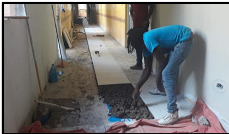
EN PASILLO: COLOCACIÓN DE PISO
