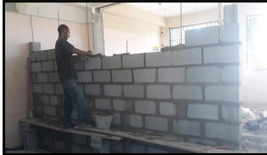
COLOCACIÓN DE BLOCK
