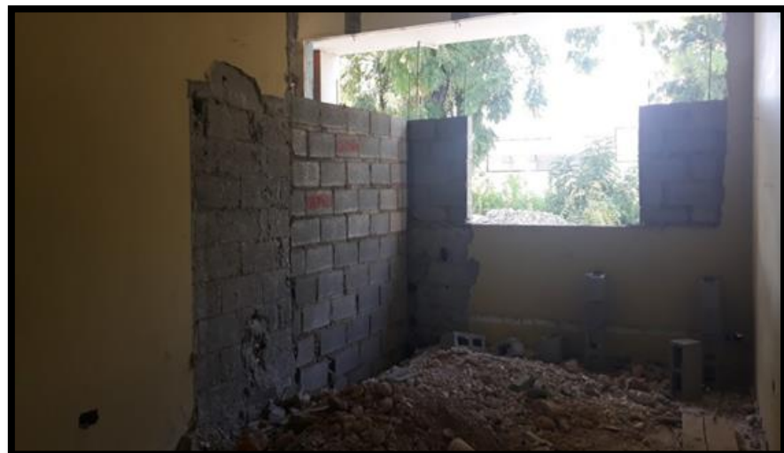
COLOCACIÓN DE BLOCK
