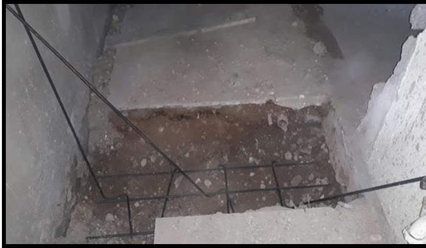
EXCAVACIÓN Y COLOCACIÓN DE ACERO EN ZAPATA
