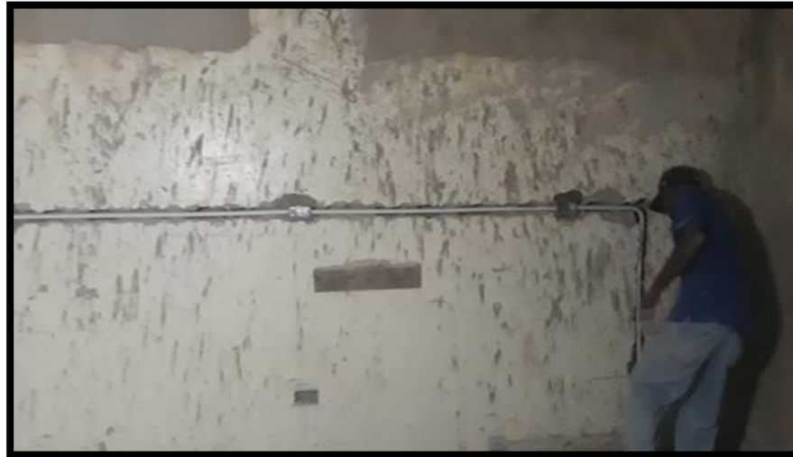
INSTALACIÓN ELÉCTRICA: COLOCACIÓN DE TUBERÍA
