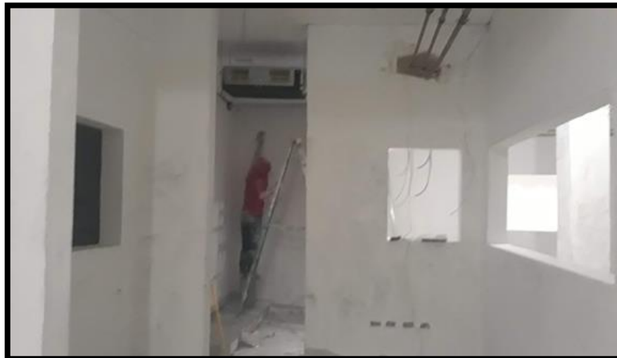
PINTURA: MASILLADO Y LIJADO
