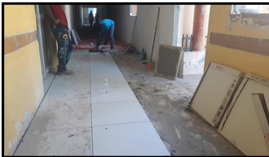
EN PASILLO: COLOCACIÓN DE PISO
