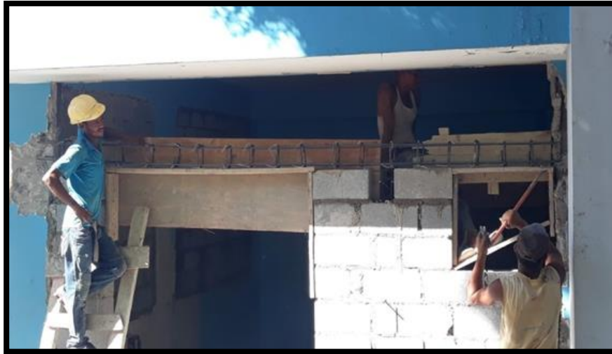
ENCOFRADO DE VIGA DE AMARRE
