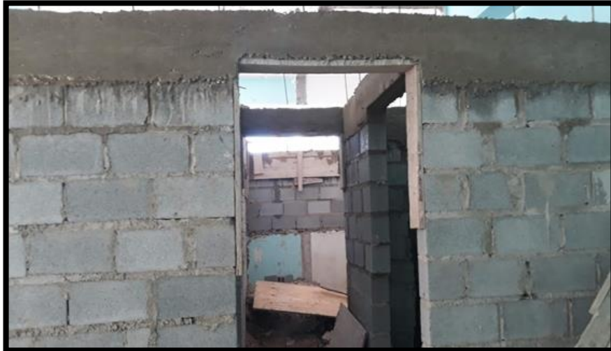
DESENCOFRADO DE VIGA DE AMARRE
