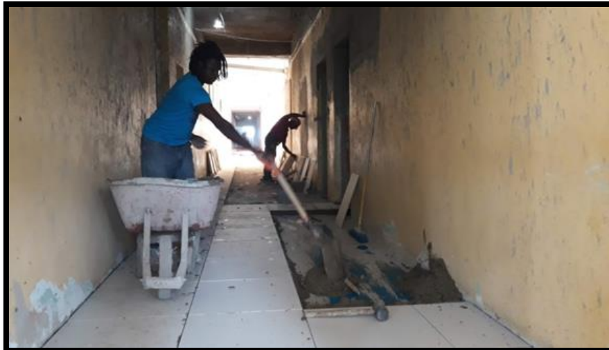
EN PASILLO: COLOCACIÓN DE PISO
