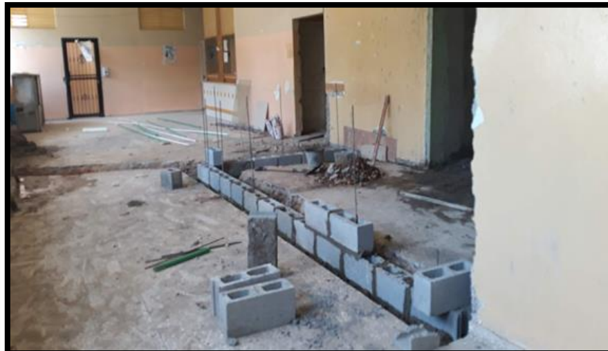
COLOCACIÓN DE BLOCK
