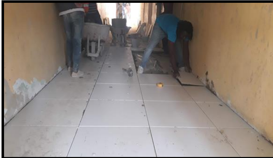
EN PASILLO: COLOCACIÓN DE PISO
