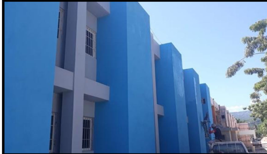
TERMINACION DE PINTURA
