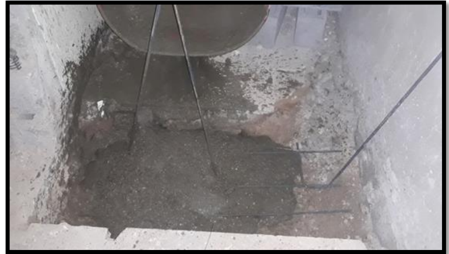
VACIADO DE ZAPATA
