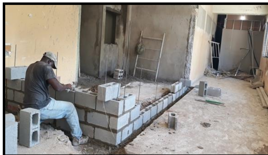
COLOCACIÓN DE BLOCK
