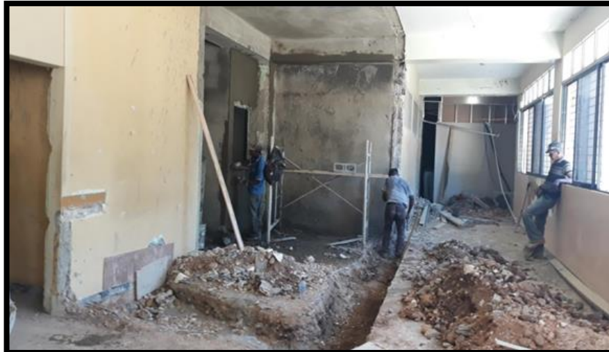
EXCAVACIÓN DE ZAPATA
