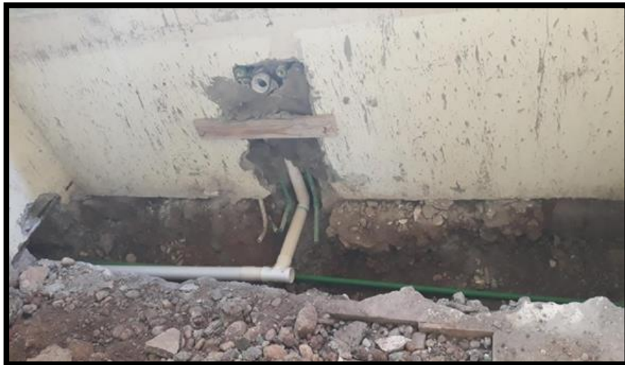
COLOCACIÓN DE TUBERÍA PARA AGUA POTABLE Y DESAGÜES
