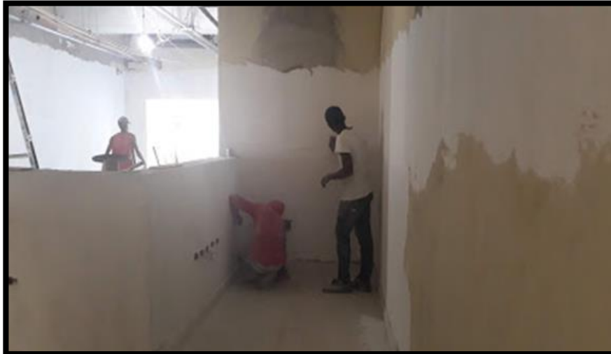
PINTURA: MASILLADO Y LIJADO
