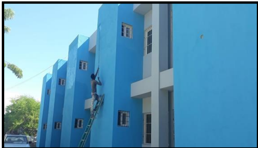
TERMINACION DE PINTURA
