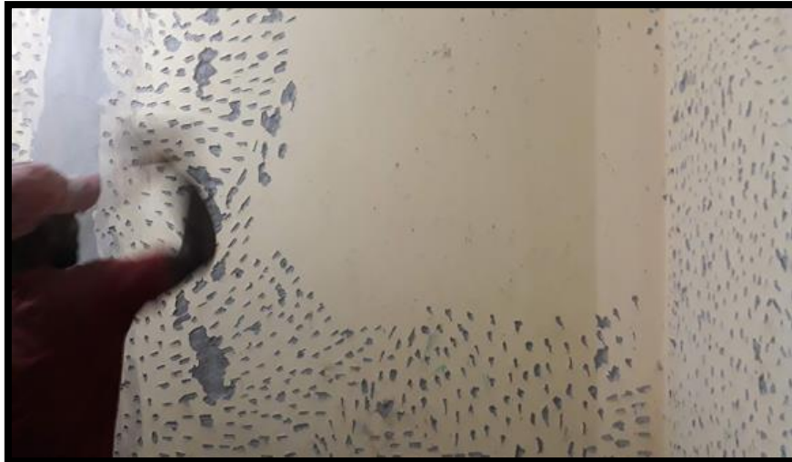
COLOCACIÓN CERAMICA DE PARED EN BAÑO
