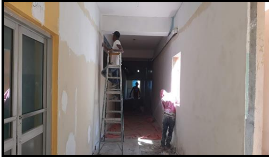
PINTURA: MASILLADO Y LIJADO
