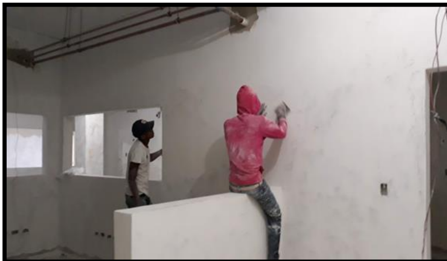
PINTURA: MASILLADO Y LIJADO
