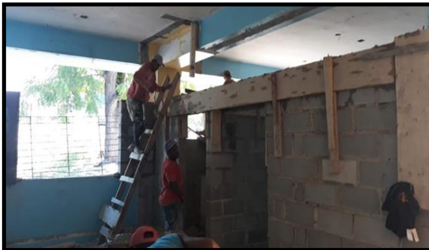
VACIADO PARA VIGA DE AMARRE
