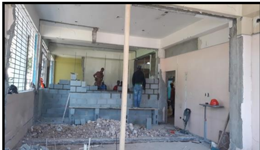
COLOCACIÓN DE BLOCK
