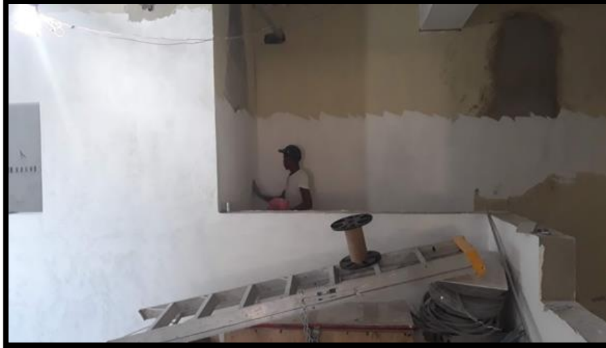
PINTURA: MASILLADO Y LIJADO
