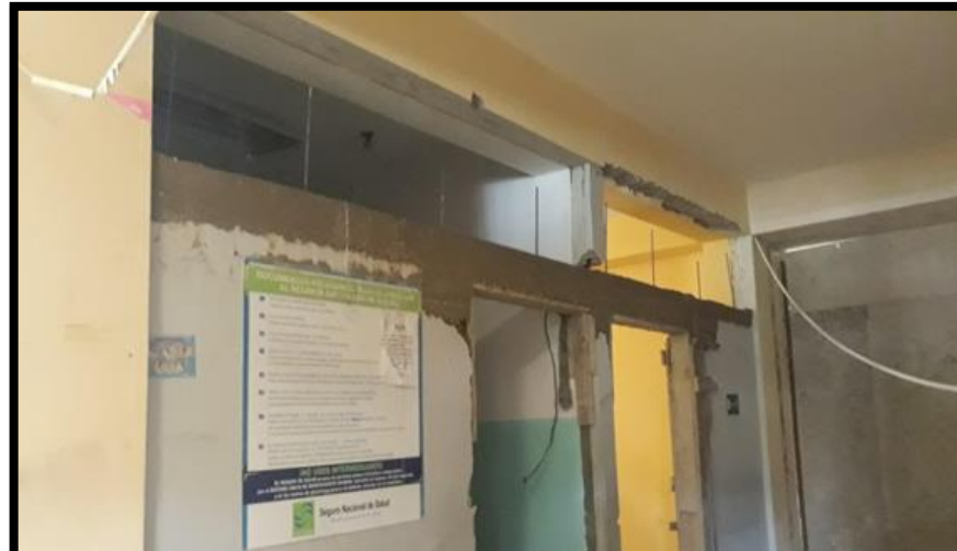
DESENCOFRADO DE VIGA DE AMARRE
