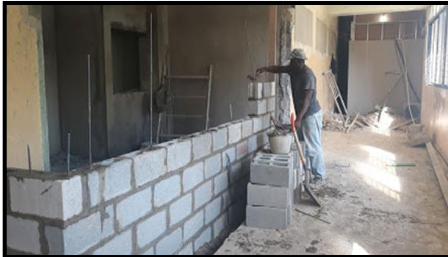
COLOCACIÓN DE BLOCK
