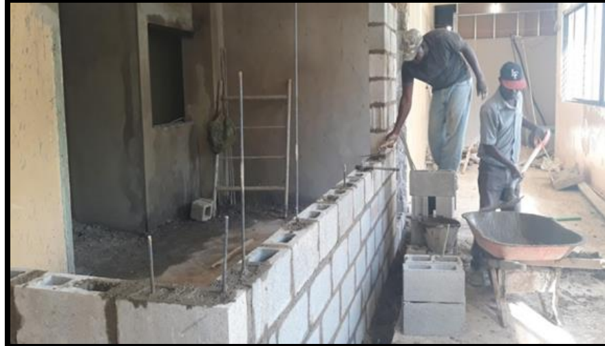
COLOCACIÓN DE BLOCK
