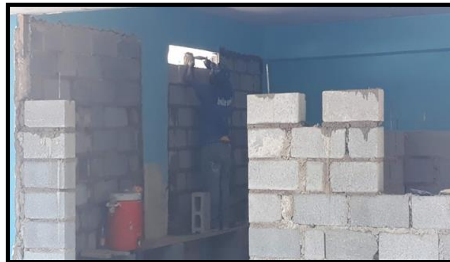
COLOCACIÓN DE BLOCK
