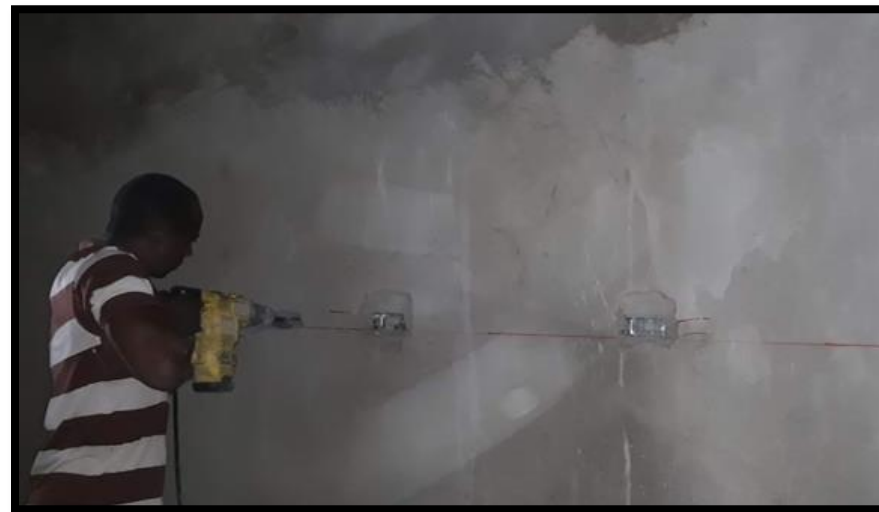
INSTALACIÓN ELÉCTRICA: RANURACIÓN DE PARED
