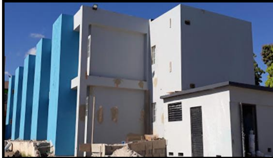
TERMINACION DE PINTURA
