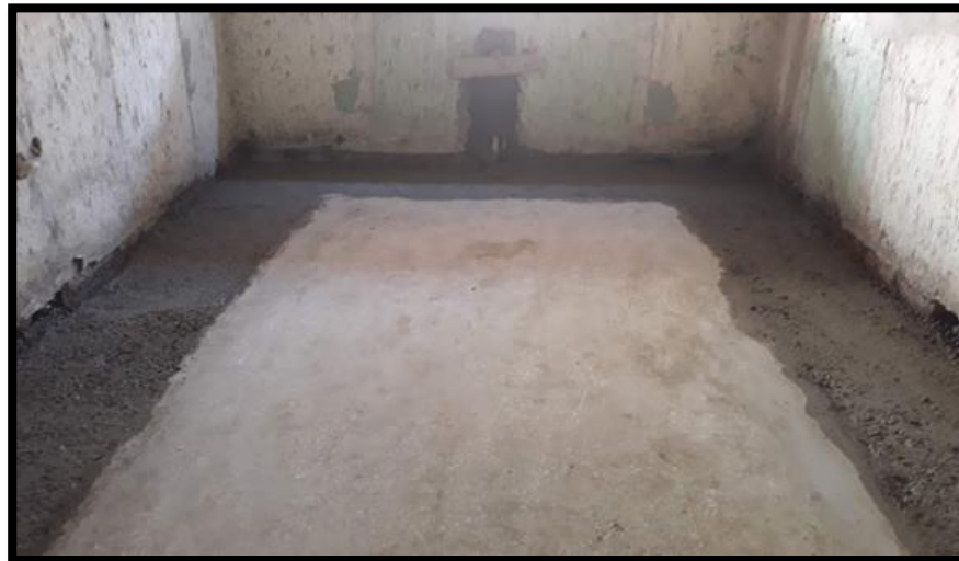
VACIADO PARA NIVELACIÓN DE PISO
