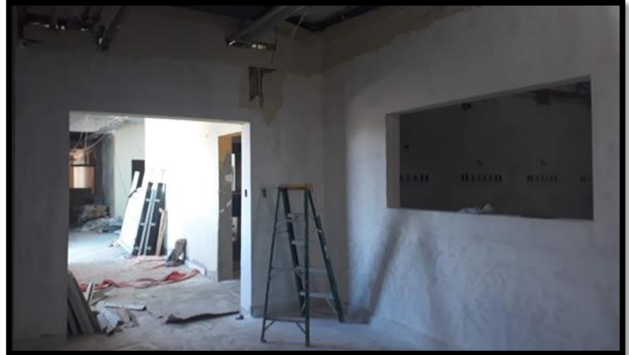
PINTURA: MASILLADO Y LIJADO
