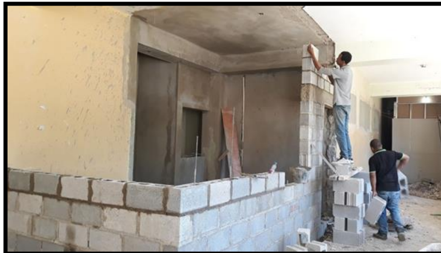
COLOCACIÓN DE BLOCK
