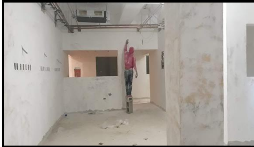
PINTURA: MASILLADO Y LIJADO
