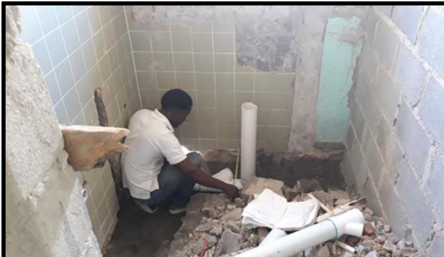
COLOCACIÓN DE TUBERIA PARA AGUA POTABLE Y DESAGÜES
