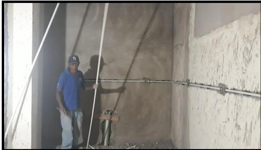
INSTALACIÓN ELÉCTRICA: COLOCACIÓN DE TUBERÍA
