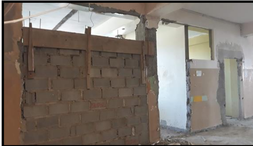
ENCOFRADO DE VIGA DE AMARRE
