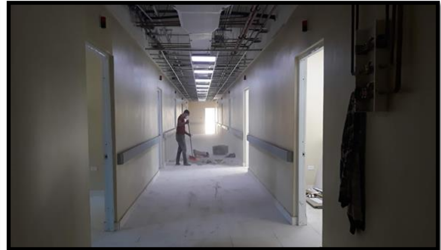
LIMPIEZA DE ESCOMBROS
