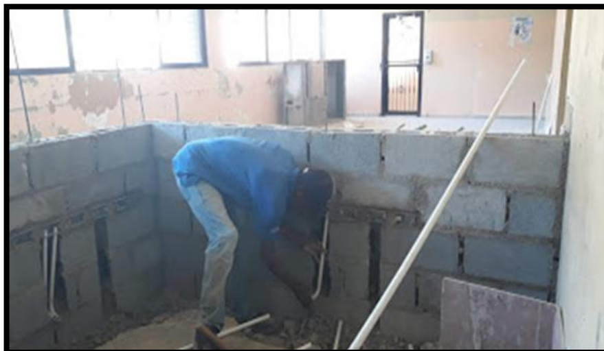
INSTALACIÓN ELÉCTRICA: COLOCACIÓN DE TUBERÍA
