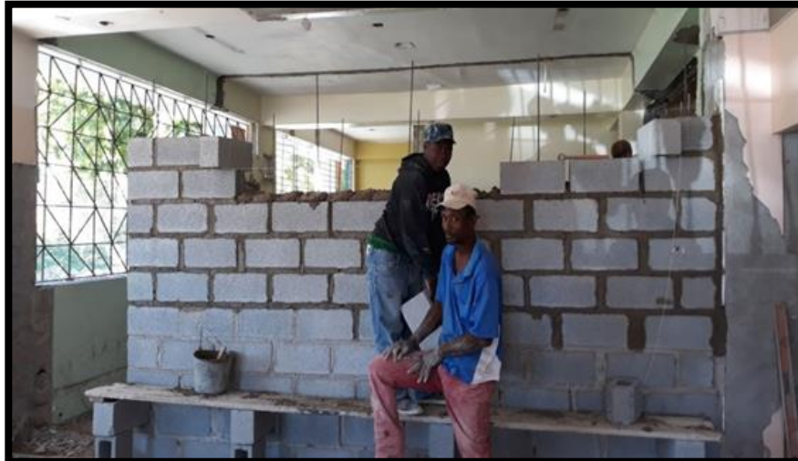
COLOCACIÓN DE BLOCK
