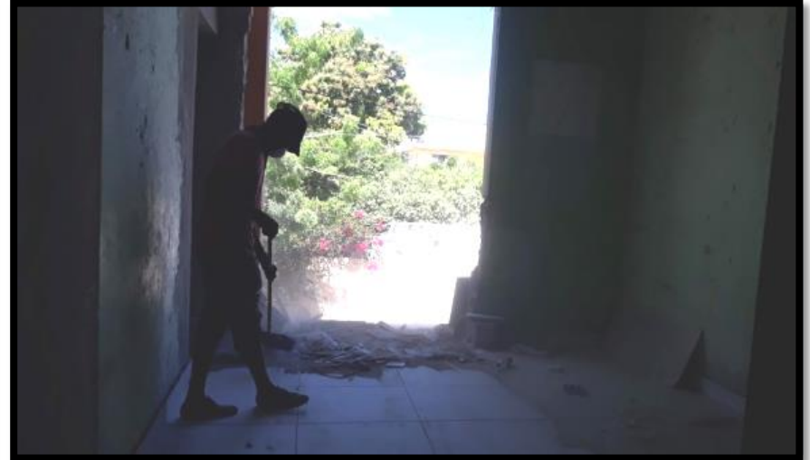
LIMPIEZA DE ESCOMBROS
