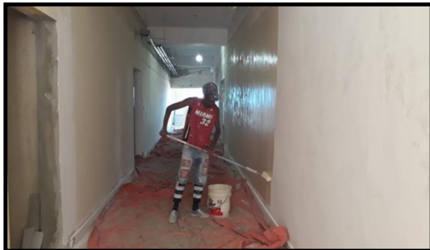
EN PASILLO: PINTURA
