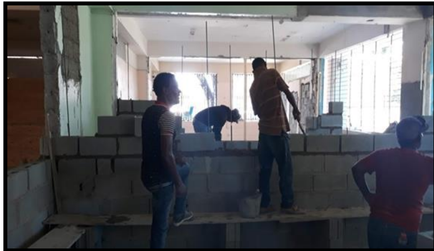
COLOCACIÓN DE BLOCK
