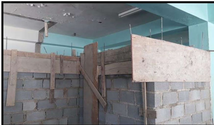
VACIADO PARA VIGA DE AMARRE
