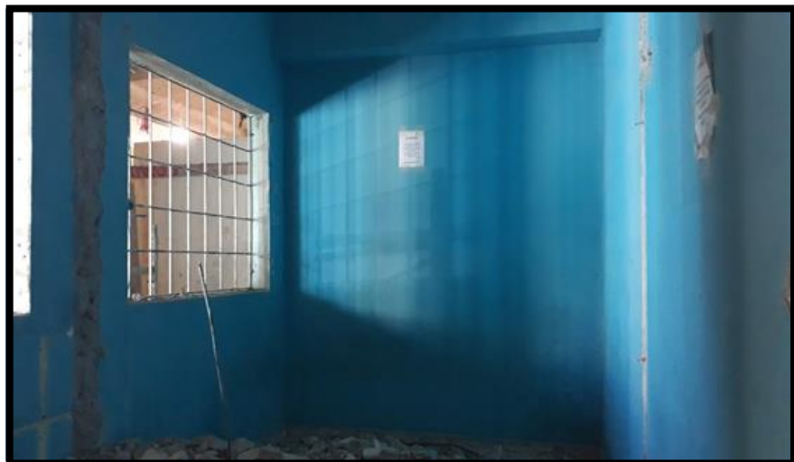
DEMOLICIÓN DE MURO, EN OFICINA DE MÉDICO
