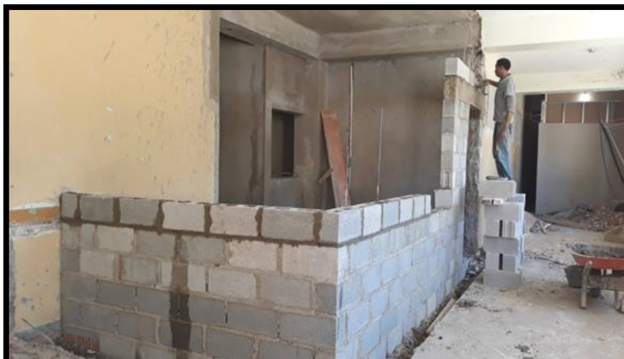
COLOCACIÓN DE BLOCK
