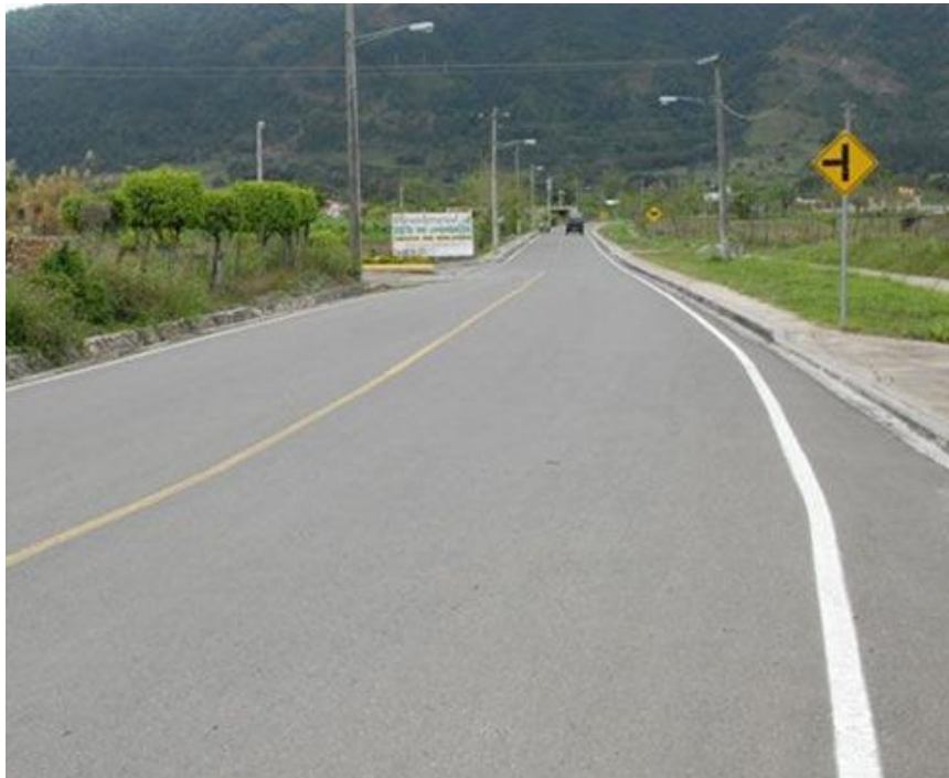
REHABILITACIÓN DE LA CARRETERA EL PINAL-LA ISLETA, SAN JOSÉ DE OCOA (POR DAÑOS OCASIONADOS POR LA TORMENTA SANDY), PROVINCIA SAN JOSÉ DE OCOA
