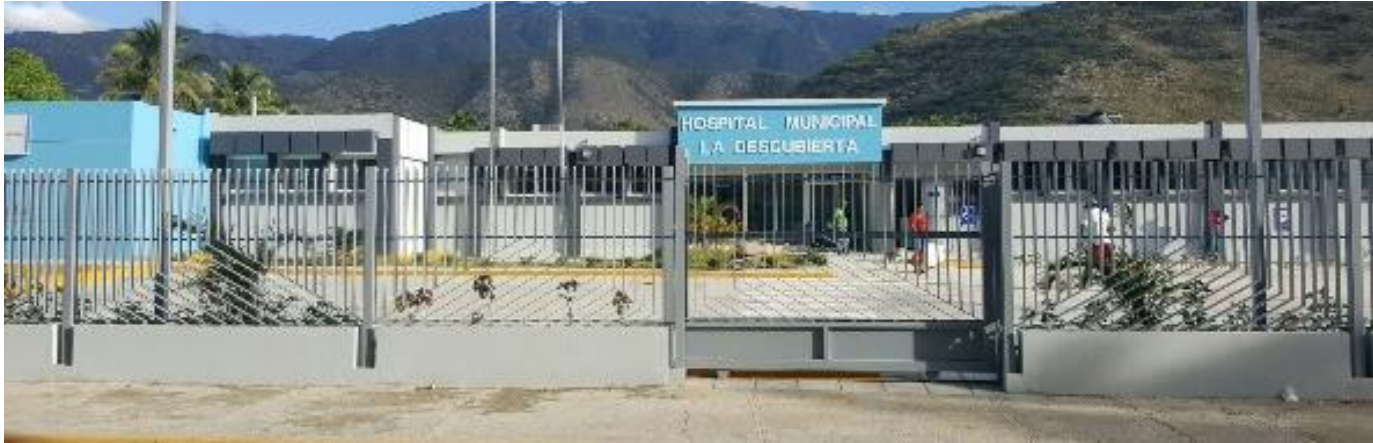
HOSPITAL MUNICIPAL LA DESCUBIERTA
