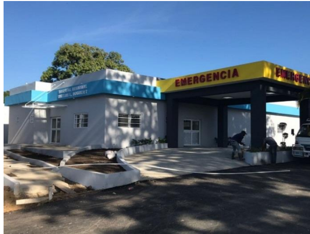
Supervisión trabajos finales remodelación del Hospital General Dr. Luis L. Bogaert, de Mao, para su inauguración.
