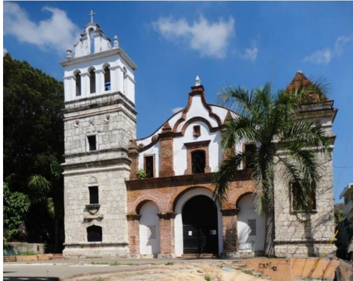
RESTAURACIÓN DE LA ESTRUCTURA DEL MONUMENTO HISTÓRICO IGLESIA SANTA BÁRBARA, ZONA COLONIAL, D.N.
