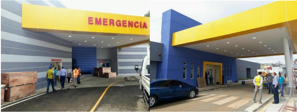
Supervisión trabajos finales reconstrucción hospital Moscoso Puello.
