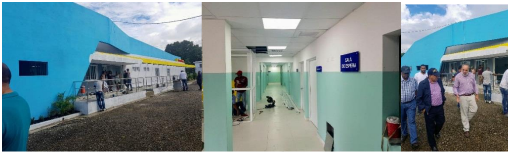
Supervisión hospital de El Mamey, Los Hidalgos, Puerto Plata, a punto de concluir su intervención.
