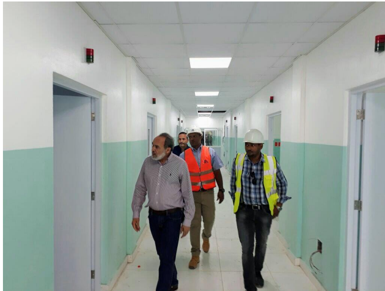
Supervisión avance ejecución trabajos reconstrucción Hospital Juan Pablo Pina, San Cristóbal.
