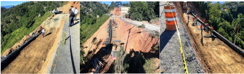
Supervisión avances construcción de carretera Los Montancitos-Los Fríos, en San Juan de la Maguana.
