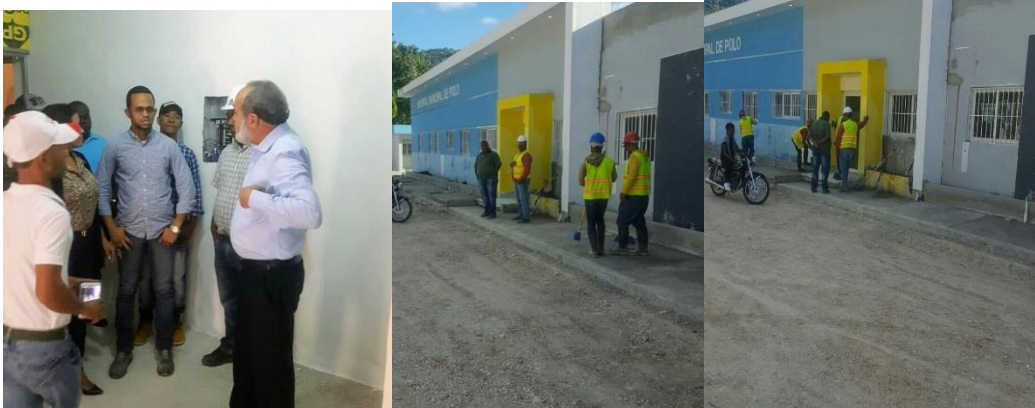
Supervisión trabajos remozamiento hospital municipal de Polo
