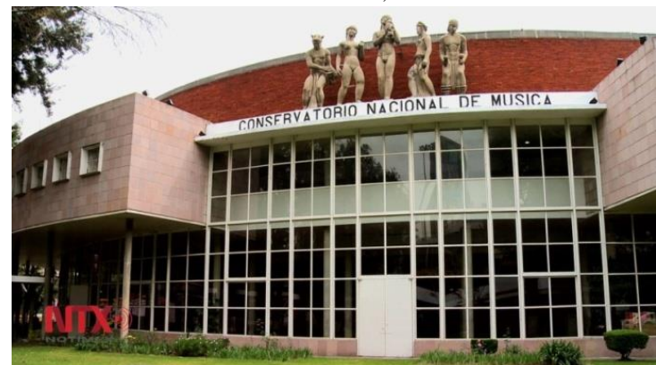
IMPERMEABILIZACIÓN DEL CONSERVATORIO NACIONAL DE MÚSICA, ARCHIVO DE LA NACIÓN Y EL INSTITUTO AGRARIO DOMINICANO, D.N.
