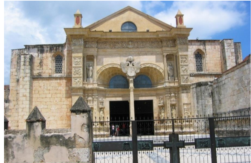
IMPERMEABILIZACIÓN TECHO RESIDENCIA PARROQUIAL, TECHO DE ESCALERA Y CÚPULA DE LA CATEDRAL PRIMADA DE AMÉRICA EN LA ZONA COLONIAL, DISTRITO NACIONAL
