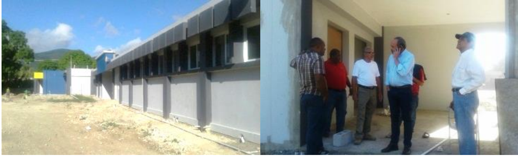
SUPERVISIÓN HOSPITAL DE LA DESCUBIERTA
