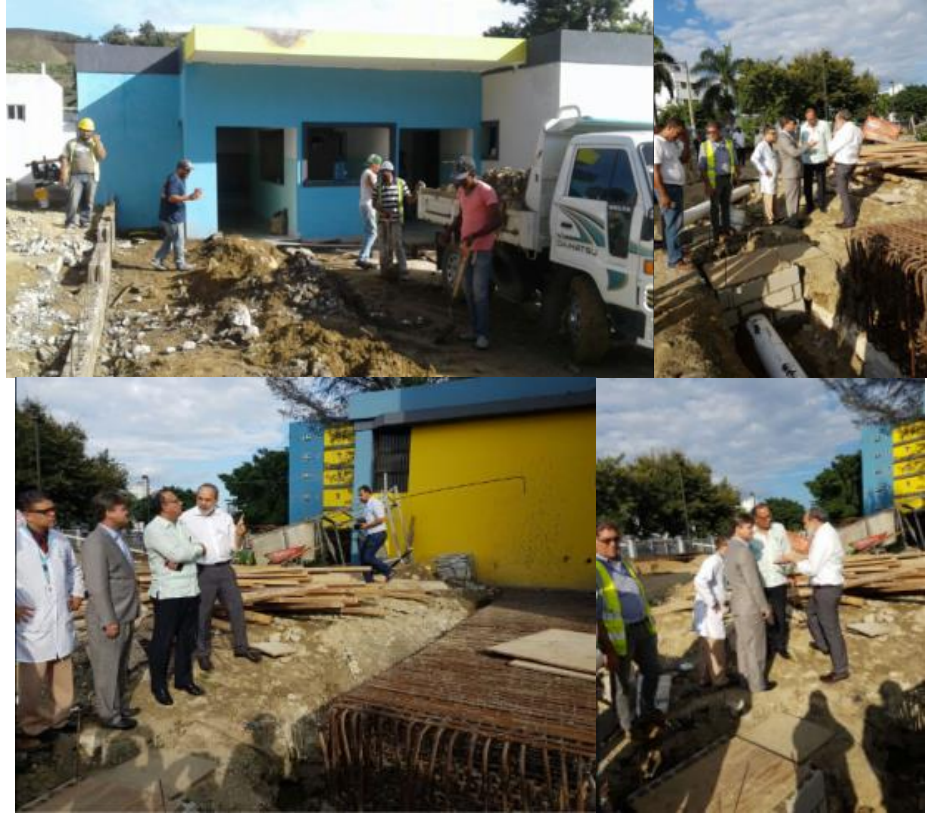
EL ING. FRANCISCO PAGÁN RODRÍGUEZ INSPECCIONA MARCHA DE LOS TRABAJOS DEL HOSPITAL CABRAL Y BÁEZ, SANTIAGO
