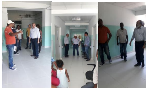
HOSPITAL MUNICIPAL DE JIMANÍ LA OFICINA DE INGENIEROS SUPERVISORES COORDINA LA TERMINACIÓN DEL PROYECTO
