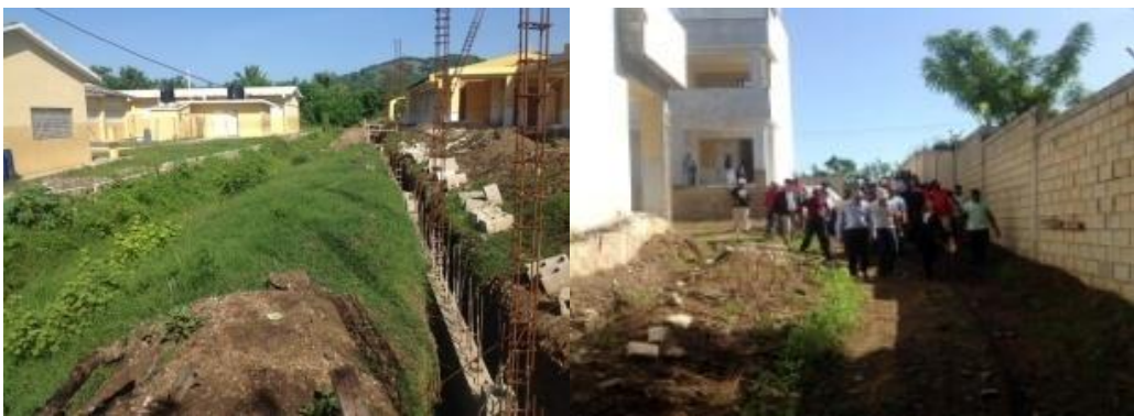
SUPERVISIÓN DE LA ESCUELA LA CHINA HATO MAYOR Y TRATAMIENTO DE CAÑADA
