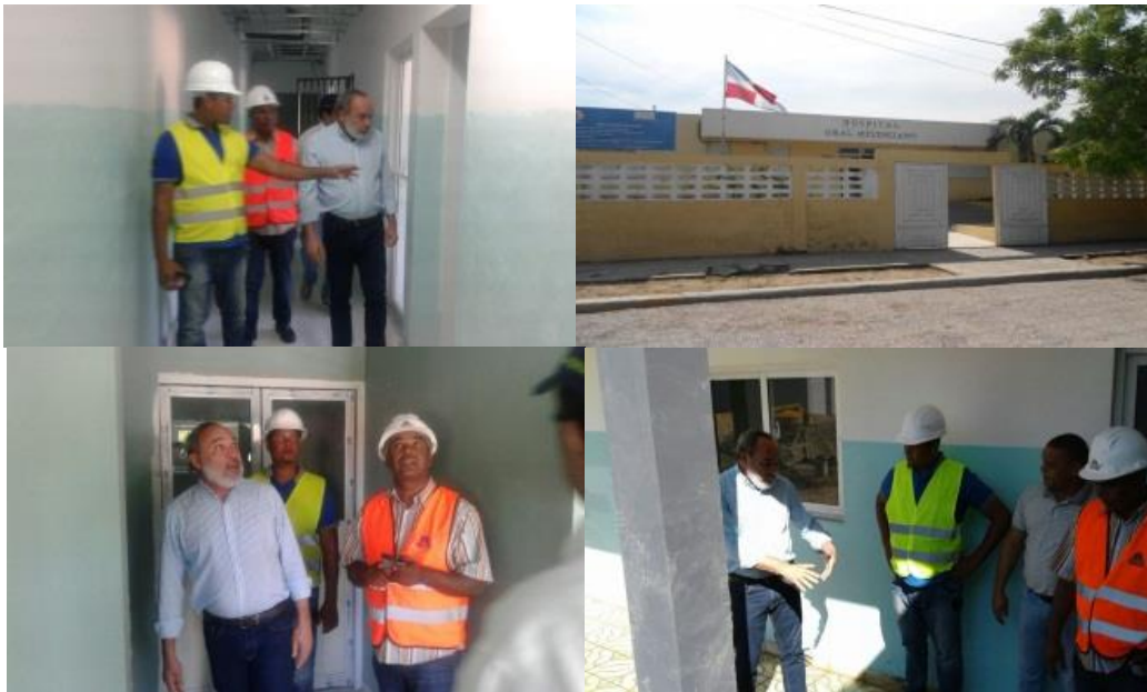
REMOZAMIENTO Y EQUIPAMIENTO HOSPITAL DE JIMANÍ
