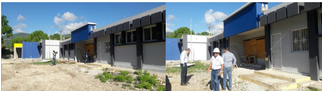
EL ING. FRANCISCO PAGAN RODRÍGUEZ, DIRECTOR OISOE VISITA HOSPITAL MUNICIPAL DE LA DESCUBIERTA, PRESENTA GRAN AVANCE EN CONSTRUCCIÓN
