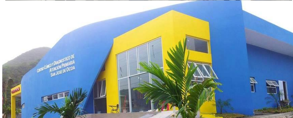
INSPECCIÓN DEL CENTRO DE DIAGNÓSTICO DE SAN JOSÉ DE OCOA
