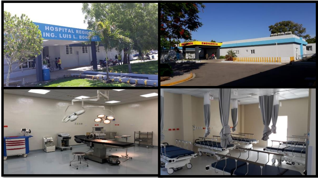
Supervisión trabajos construcción Hospital Luis L. Bogaert
