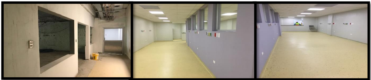
Seguimiento trabajos de construcción Hospital Arturo Grullón
