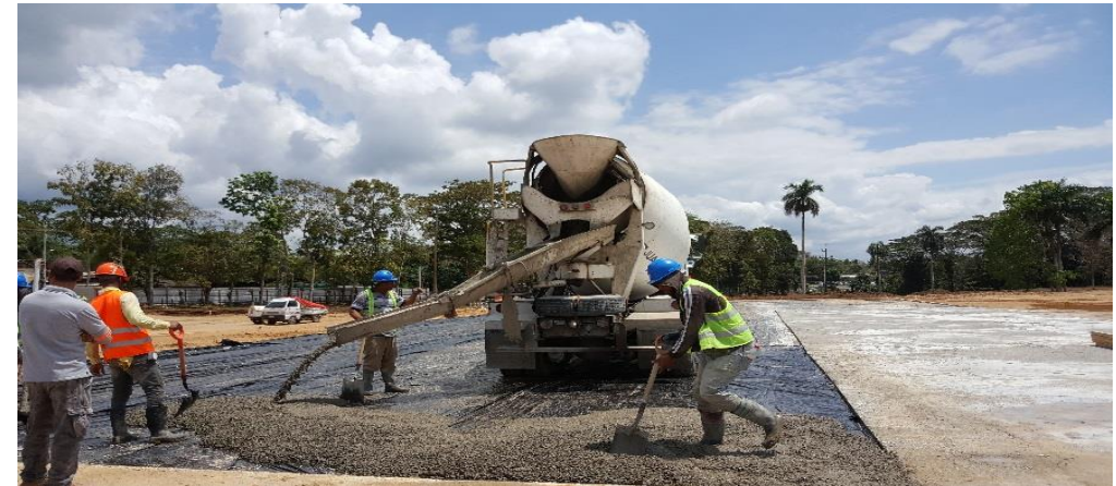
CONSTRUCCIÓN HOSPITAL SAN FRANCISCO DE MACORIS, PROVINCIA DUARTE
